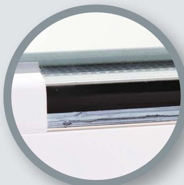
Die Sicherheitsverglasung P4A wird mit Spezialkleber umlaufend im Glasfalz des Flügelprofils verklebt. So kann bei einem massiven Einbruchversuch das Glas nicht aus dem Flügel herausgedrückt werden.
